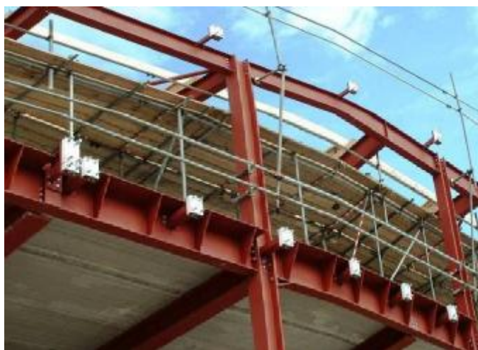
Slika 16. "Isokorb"ova jedinica vezana za čelični ram [12] Figure 16. "Isokorb" units attached to steel frame [12]
